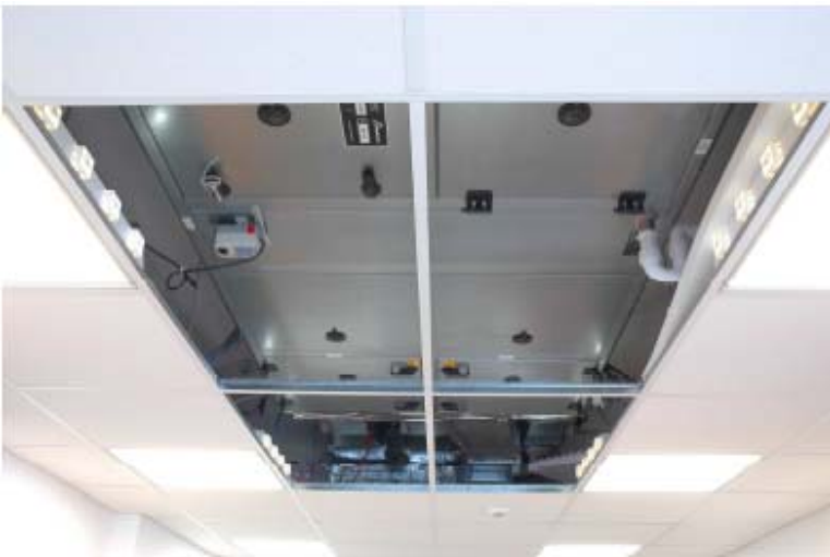
图2: 每台紧凑型装置的深度仅为360mm, 但可以提供高达1500 m 3 /h的空气流量, 并且配备有高效的热回收系统(图片: Walter Bösch GmbH & Co. KG)
